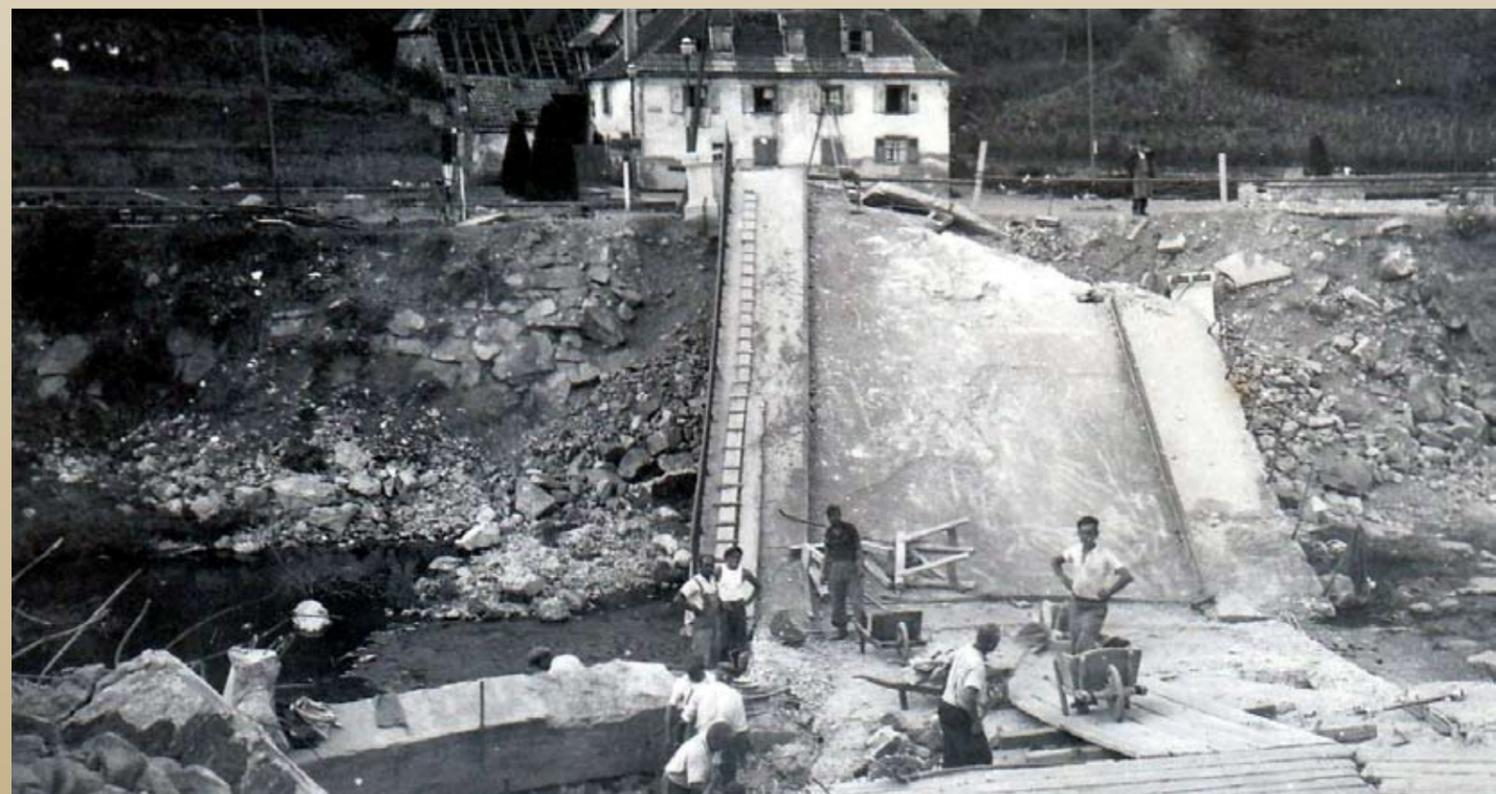
Le pont Turenne avait été endommagé durant le conflit de 1914. Il fut reconstruit en 1931 en remplacement d'une passerelle métallique. Il s'agissait d'un pont en béton armé qui ne perdurera donc que jusqu'en juin 1940. Les documents photographiques nous montrent que tout le tablier du pont s'est effondré dans le lit de la Fecht.
